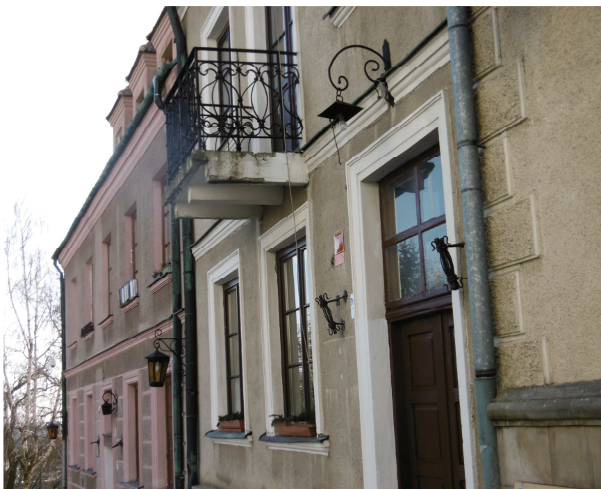
Zdj. Nr 3 Elewacja wschodnia – balkon do remontu
