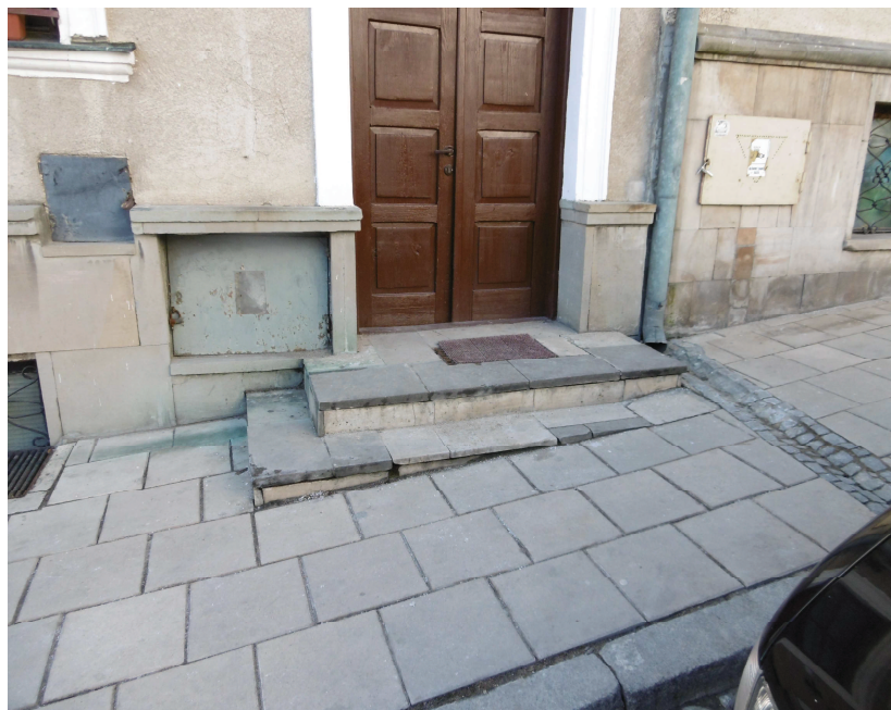
Zdj. Nr 5 Elewacja wschodnia – schody do remontu i fragment cokołu
